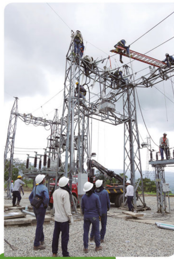
Registro Fotográfico #1 cumpliendo normas de seguridad con los procedimientos implementados:
